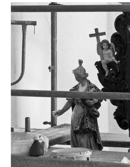
Sanierung der Kirche in Grünberg
